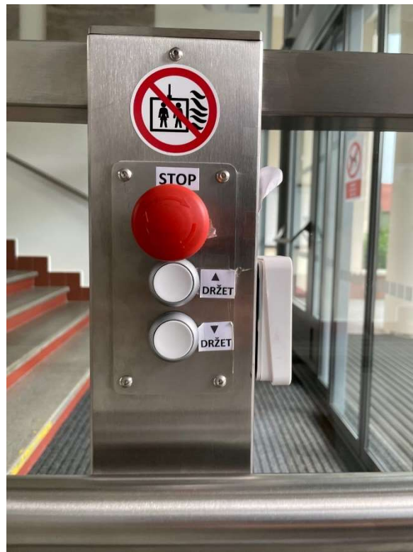
Obr. 3 – Ovládání hydraulické plošiny
