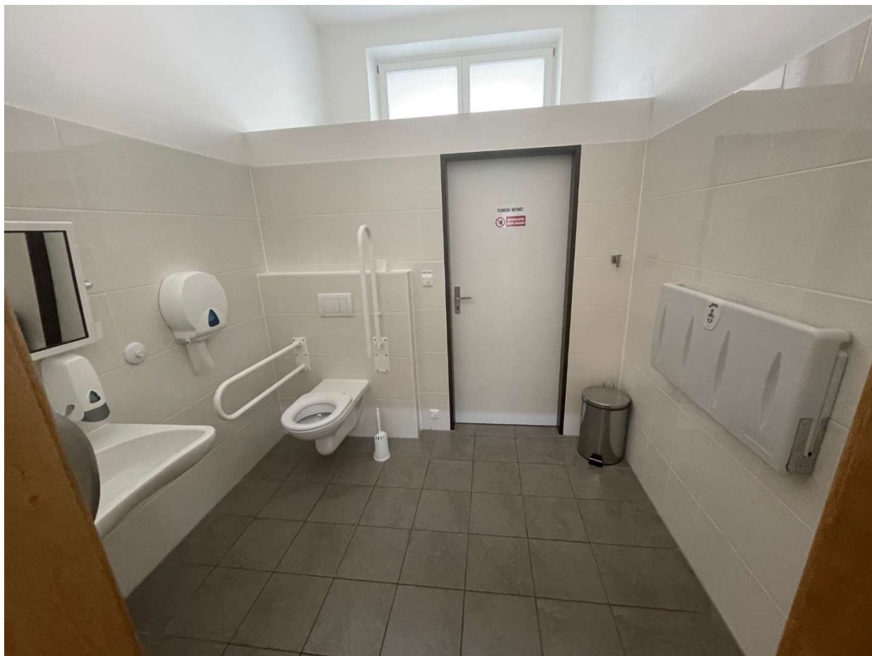
Obr. 6 – Bezbariérové WC u hlavního vstupu v 1. NP – celkový pohled (na pravé stěně sklápěcí přebalovací pult)
