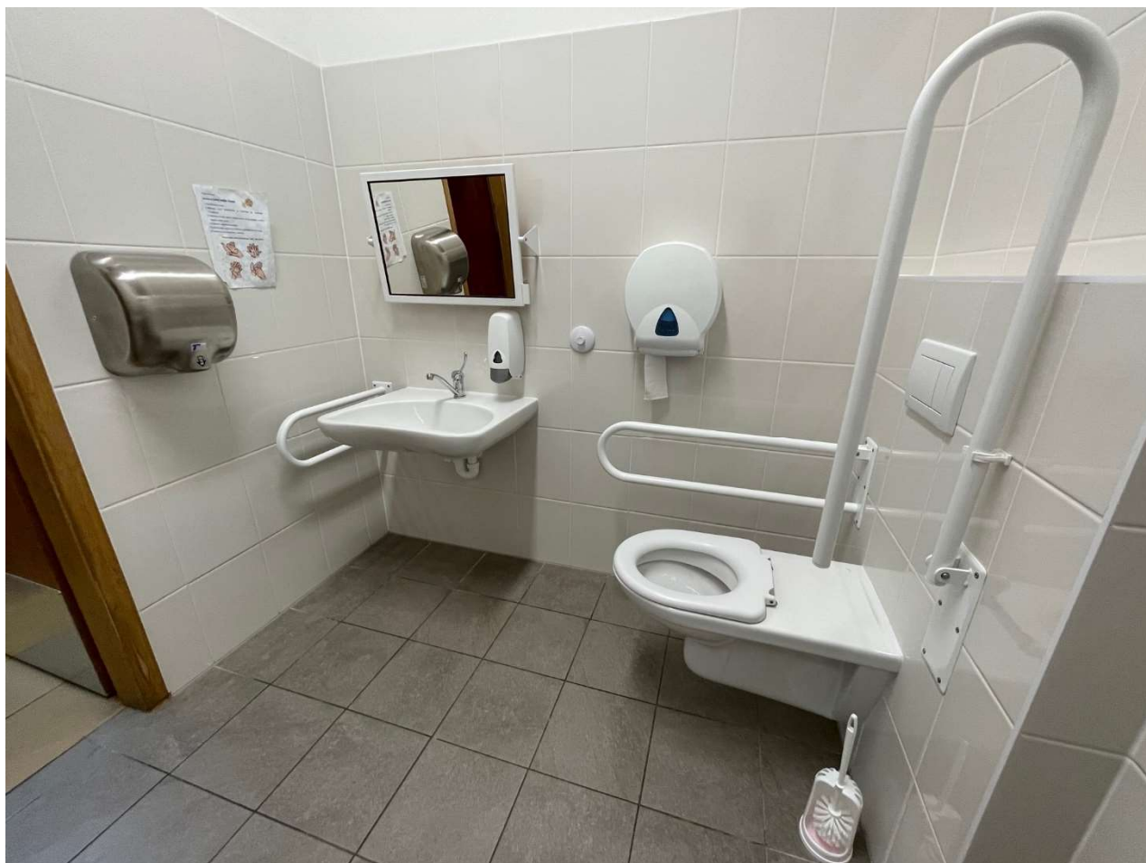
Obr.7 - Bezbariérové WC u hlavního vstupu v 1.NP
