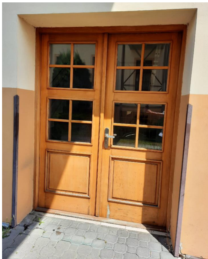
Obr. 3 Bezbariérový vstup do budovy z nádvoří
