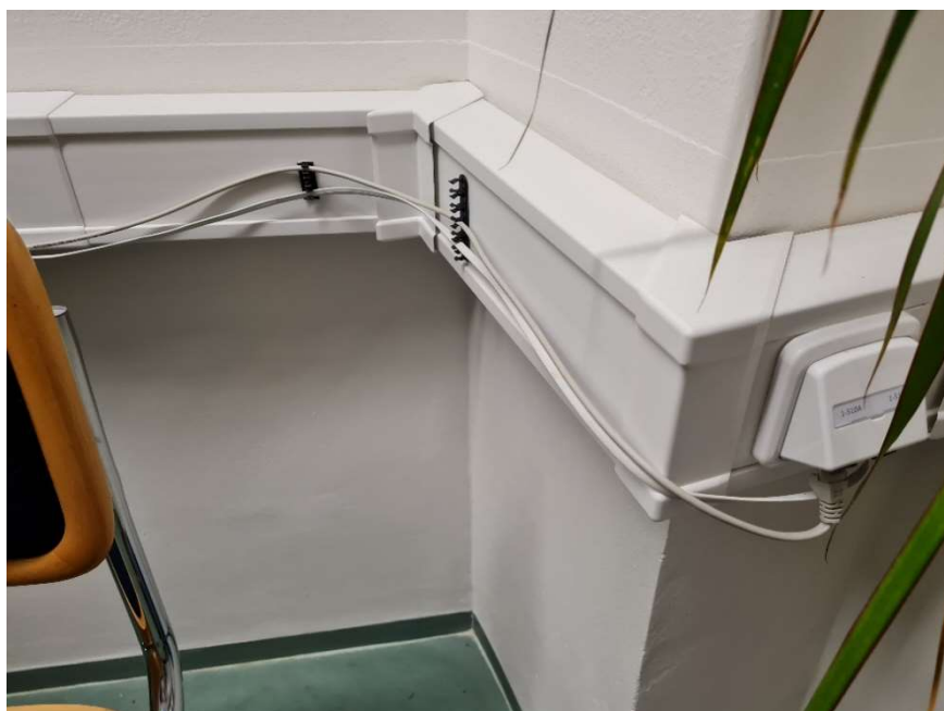
Ukázka lištování ve 4. patře a vedení kabeláže
