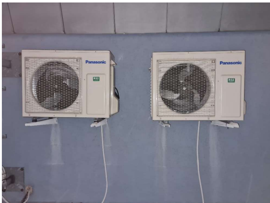
Venkovní část výměníku na střeše
