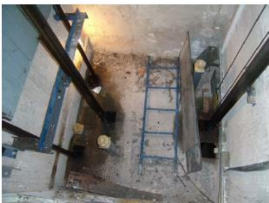
Pohled do prohlubně šachty
