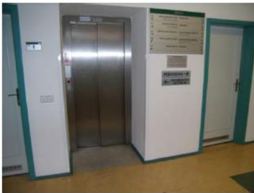
Nástupiště v přízemí – výchozí stanice
