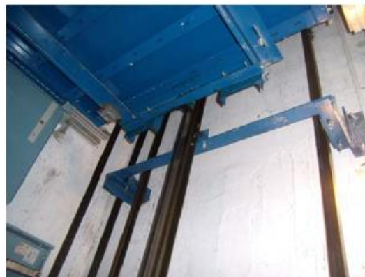
Detail kotvení původních vodičků
