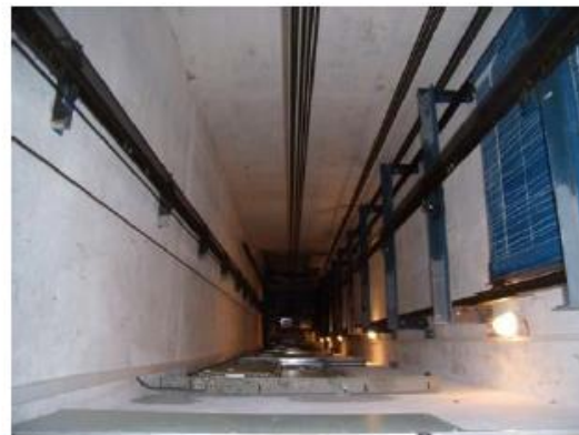
Pohled do šachty z vrchní stanice
