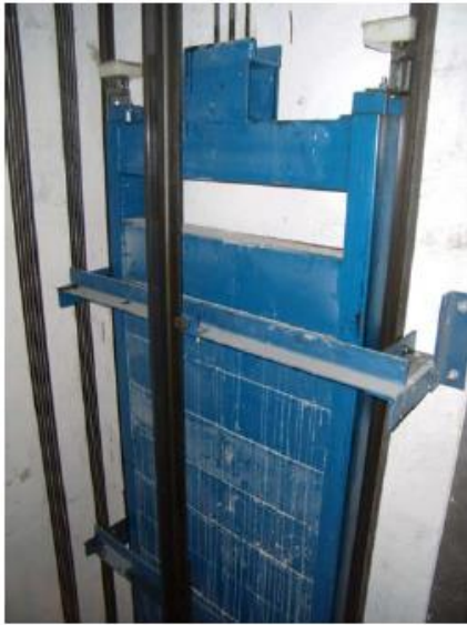
Původní protiváha, ocel + beton
