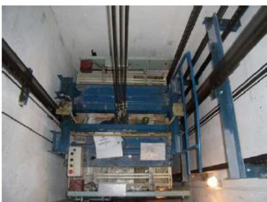
Pohled do výtahové šachty s kabinou
