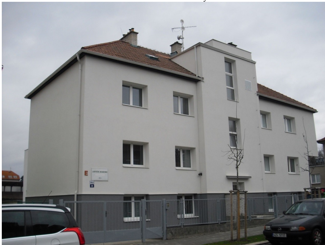
JA – rekonstrukce budovy E
